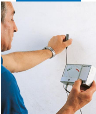
Проверка на влажността на гипсовата мазилка
